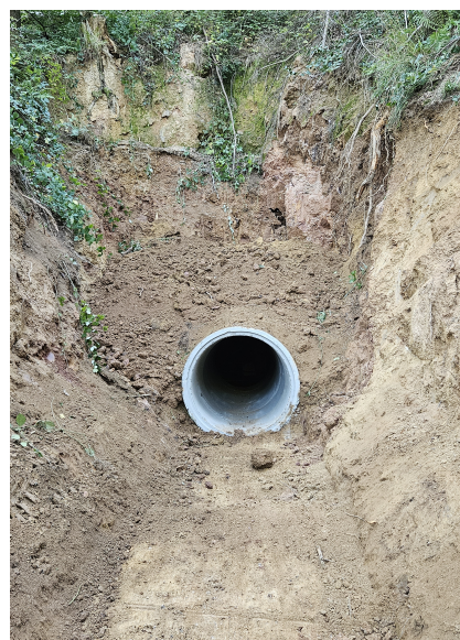
Sécurisation au niveau d'une cavité en Alsace © L.Thiriet, G.Hommay
