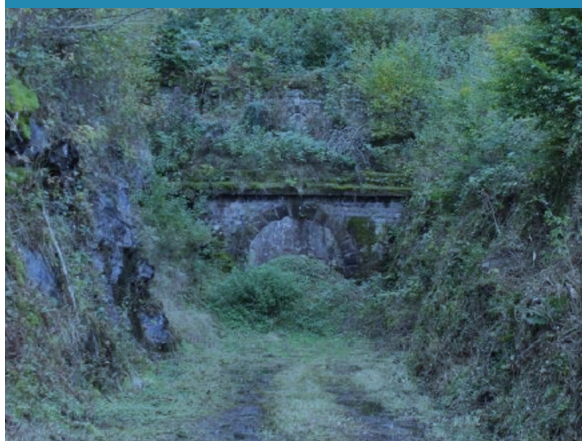
Entrée nord avant travaux
