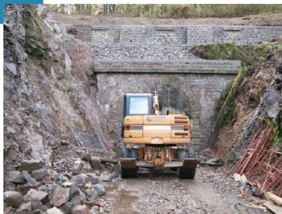
Entrée nord pendant les travaux
