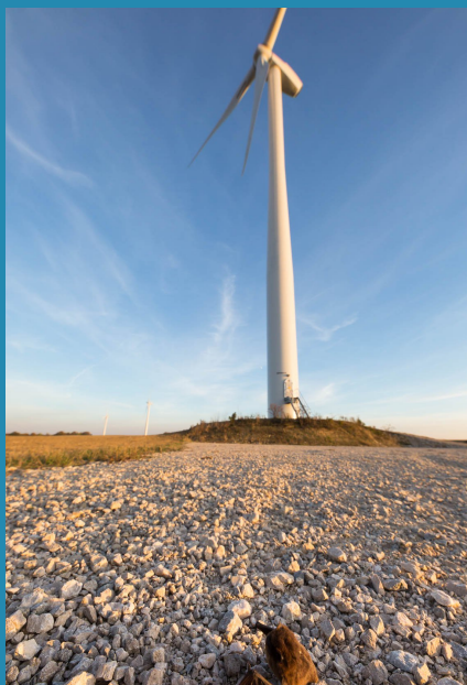
Figure 11 : Les éoliennes sont des installations mortifères pour les chauves-souris ©MASSIT Philippe.
