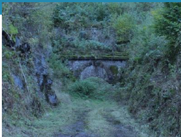
Entrée nord avant travaux
