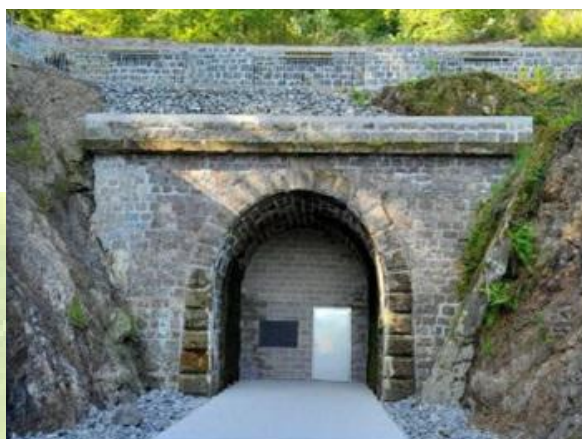
Entrée nord après travaux
