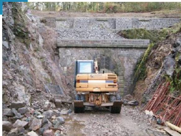
Entrée nord pendant les travaux
