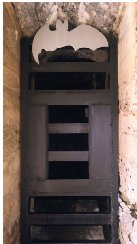
Sécurisation au niveau d'un ancien site militaire en Alsace © G. JIMENEZ
